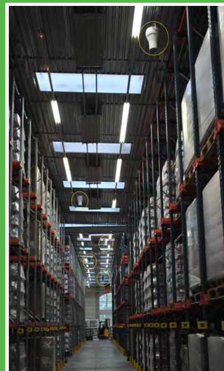
Lagerhalle Mautner Markhof, Wien
